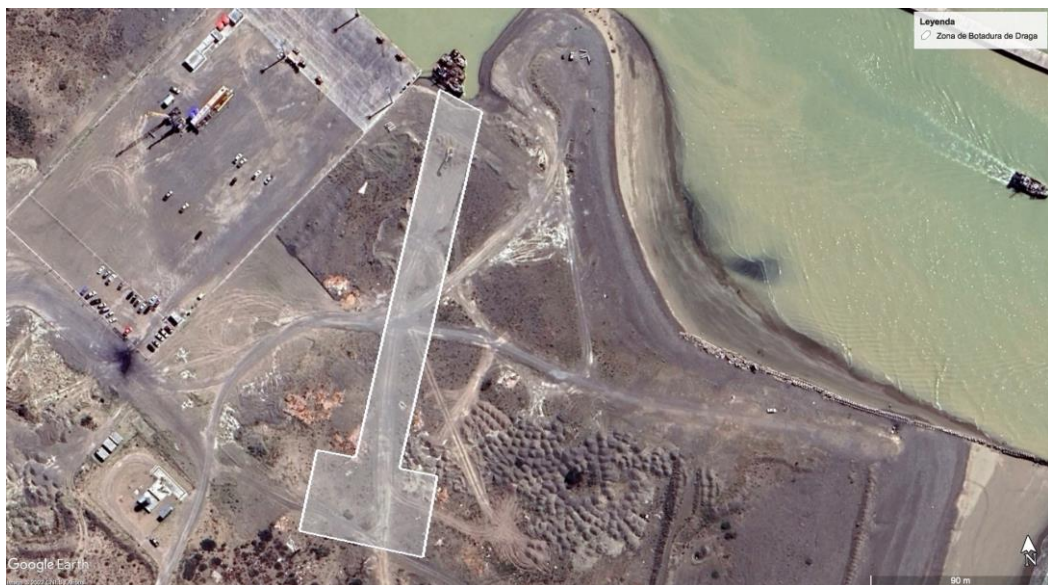
Imagen 15: áreas afectadas a compactación y nivelación de terreno para botadura de la draga.
